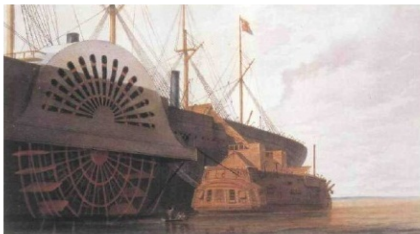
Tendido del cable a bordo del Great Eastern, 1866.
